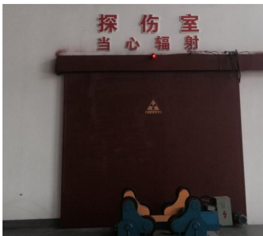
图 6-3 曝光室工件门电离辐射标志和警示灯
